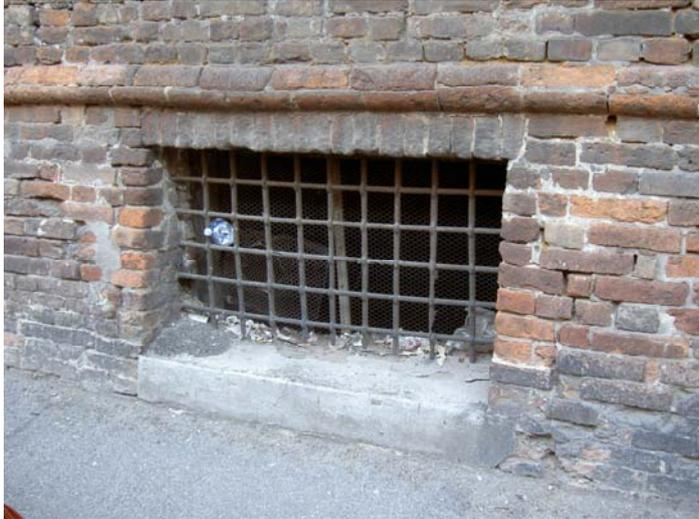
Fig. 4 – Palazzo Manna. Una delle due bocche di lupo nella porzione più orientale del palazzo su via Manna, realizzata in rottura nella muratura dello zoccolo.
