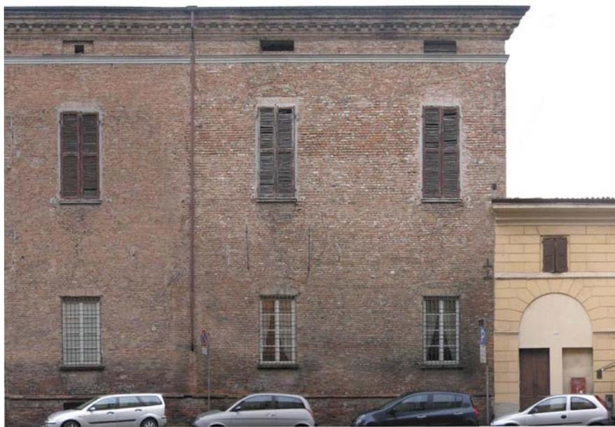
Fig. 16 – Prospetto di palazzo Manna su via Ruggero Manna: è evidente il giunto orizzontale all'altezza della linea di gronda del rustico.
